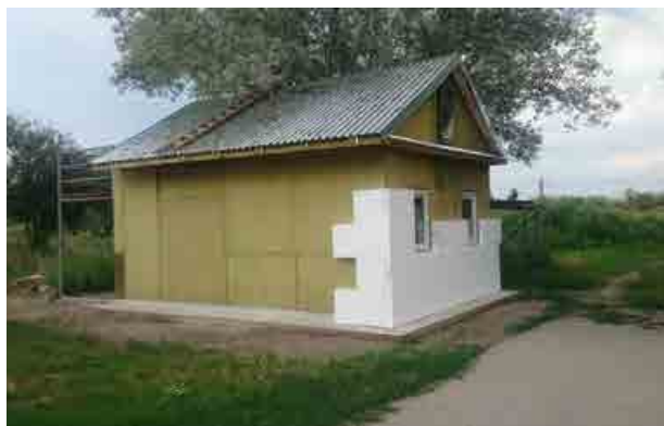
Skupina VSE Holding darovala bubnové káble, ktoré poslúžili pri výstavbe domčeka pre ľudí v núdzi.
